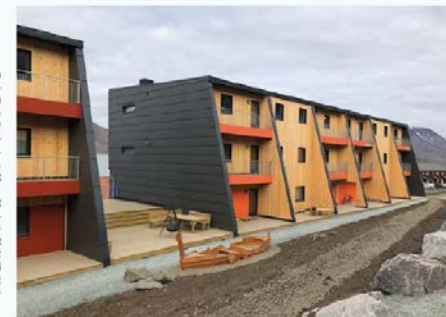
Del seks nye bustadblokkene til Statsbygg i Longyearbyen er eit av pilotprosjekta i SFI Klima 2050 med smart dampsperre i yttertak. Blokkene er bygd som modular av Skanska Husfabrikken. Foto: Inger-Johanne Tøllås, Statsbygg
